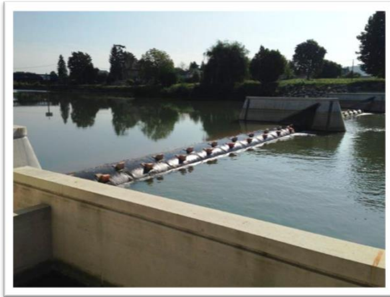
Photo n° 43: Inflatable rubber dams (doc. T. Vanden Eynde)
